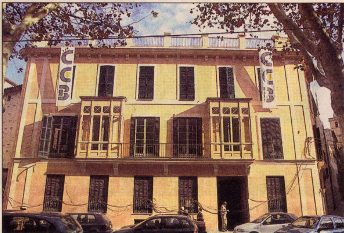
La reforma ha respetado la fachada principal del edificio. FOTO: TORRELO
